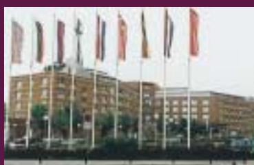
Instalacje klimatyzacyjne, chodnicze
